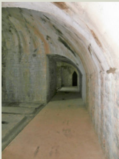
Corridoio di Batteria della cannoniera di Cotici
