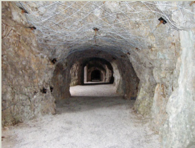
Corridoio di Batteria della Cannoniera di Cima 3 del Monte San Michele
